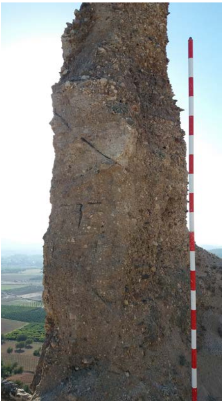
Figura 7. Muro sur del torreón, cara externa. Se observa la huella de la soga y debajo el pasador para refuerzo de la estructura interna del tapial.
