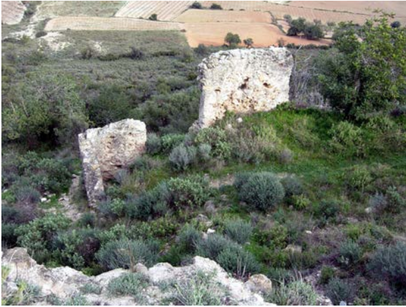
Figura 15. Pastador-cocina . Estado previo.
