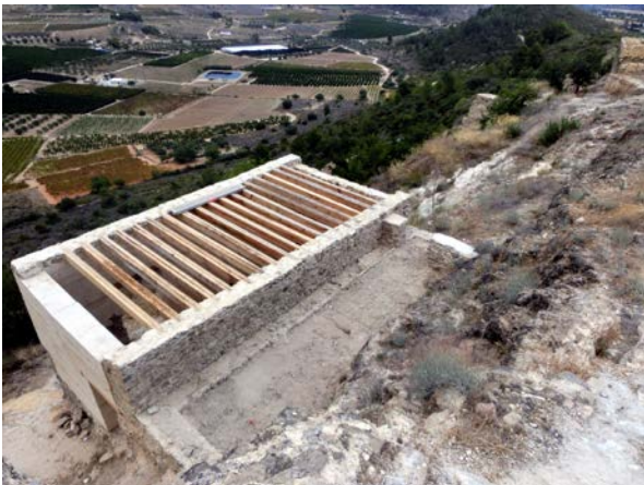
Figura 19. Pastador-cocina . Colocación de las vigas (2013).
