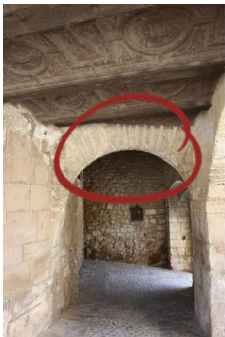
Detalle del arco de aparejo califal a sogá y tizón en la Torre de la Aljama. Fotografías de Laura Martín Burgos.
