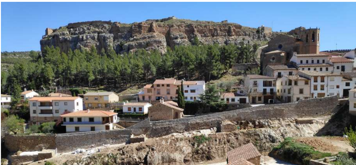
Frente restaurado con torres 6, 6, 7 y 8, donde se localizaba la "senda de las Torrecillas". Fotografía de Rosario Serrano Pérez.
