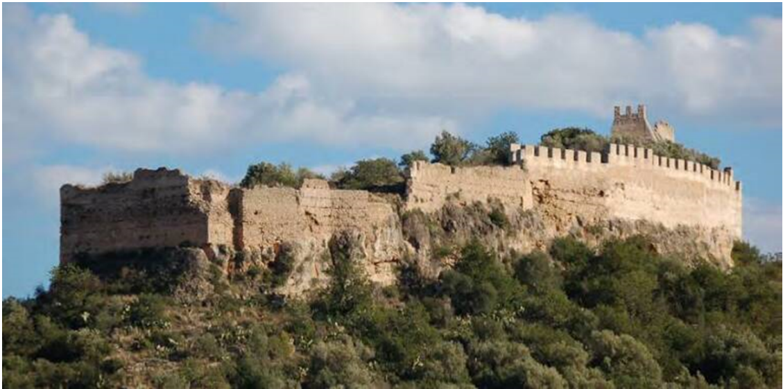
Fig. 2. Tram NO de la muralla del Castell de Corbera
